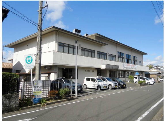
南公民館 市内でも利用が多い。1階入口脇に南分館がある。耐震診断済み、補強の必要は無しに。
