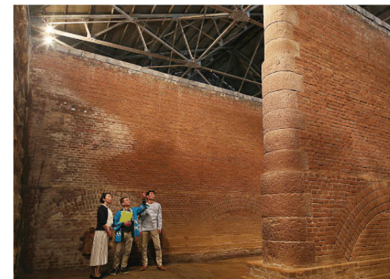
▲北吸浄水場配水池内部
