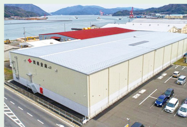
▲舞鶴倉庫(株) 21号倉庫を新設
