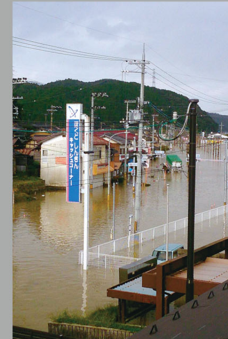
▲平成29年台風21号 由良川流域（志高地区）
