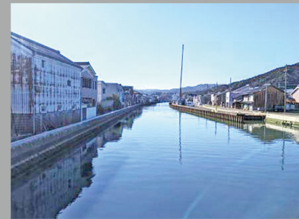
▲高野川浸水対策工事
