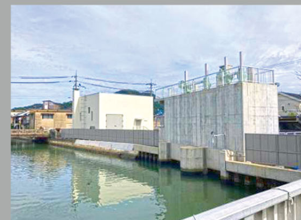
▲完成した大手ポンプ場
