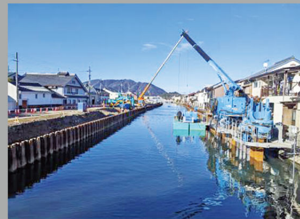
▲高野川浸水対策工事
