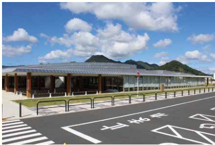
【あそびあむほか前島みなと公園】 平成24年3月 12,133㎡
