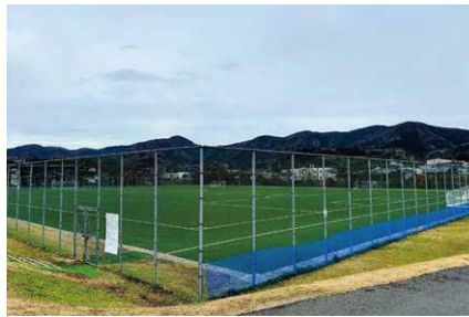
【伊佐津川運動公園】 平成29年6月 47,643㎡
