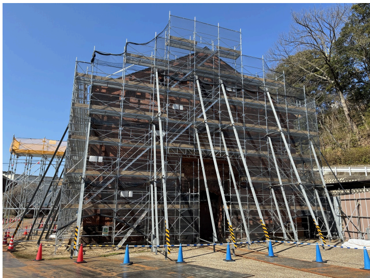
修理のために足場で囲われた赤れんが6号棟
