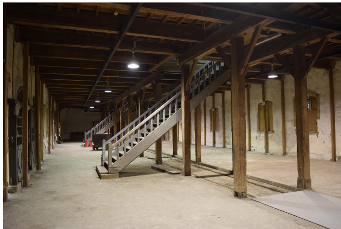
赤れんが6号棟の内部
