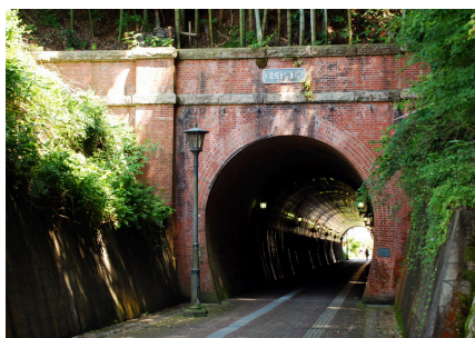
国登録有形文化財 旧軍港引込線北吸隧道(ずいとう) 明治37(1904)年 2016年撮影
