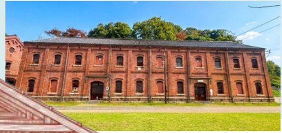
長手側（建物正面）から見る
