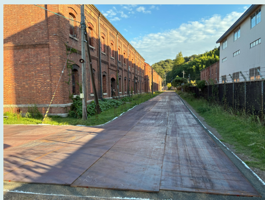
(右) 鉄板を敷き終えた様子
