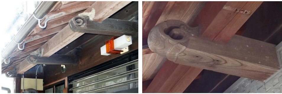
図12 「厨子二階C」の1階庇下の構造(左)と腕木先端形状「水雲」(右)
