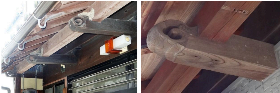
図12 「厨子二階C」の1階底下の構造(左)と腕木先端形状「水雲」(右)
