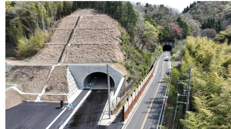
西側トンネル坑口付近（4月16日現在）
