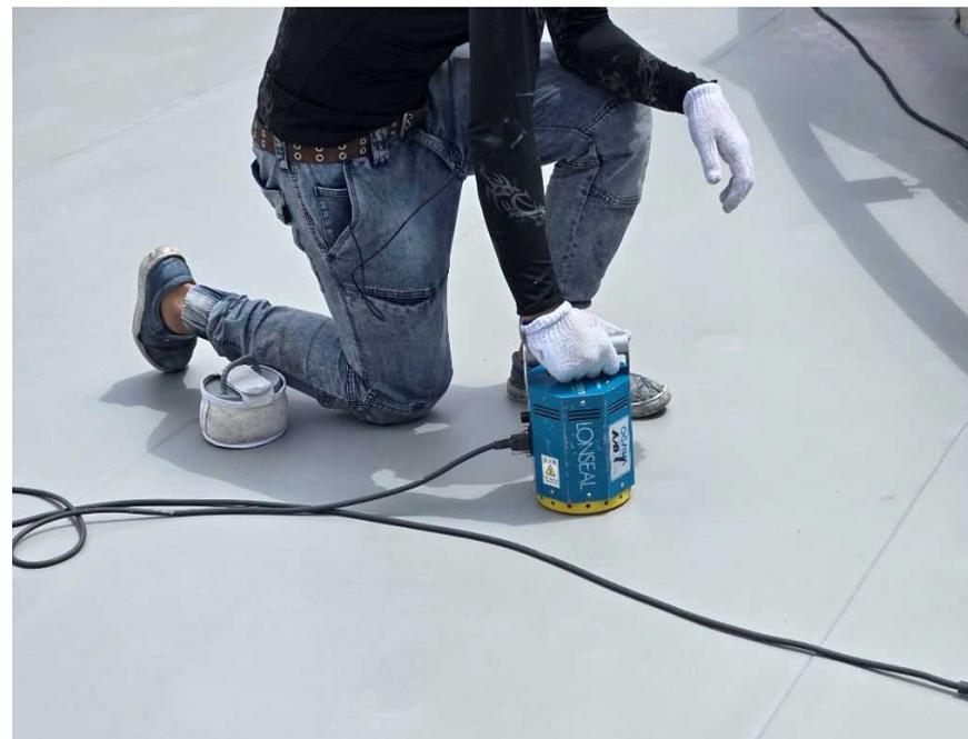
機械固定シート防水 誘導加熱接合状況
