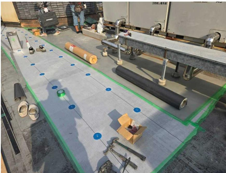
機械固定シート防水 IHディスク 設置状況
