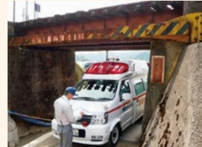
道幅が狭く自動車のすれ違いが困難な道路に待避所を設けたり、高架下を通る道路の高さを切り下げたりすることで、救急車など緊急車両がスムーズに通行できるよう努めています。
