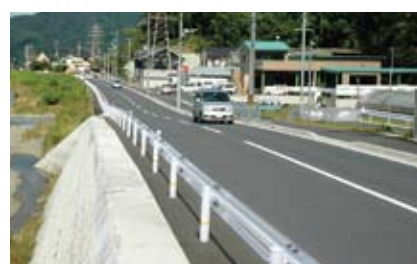
▲急勾配の解消と拡幅、歩道の整備により見通しが良くなった市道九杵橋線
