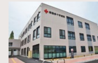
▲竣工したリハビリテーションセンター
