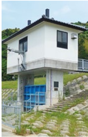
▲堤防に設置された樋門(ひもん)
