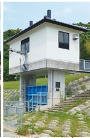
▲堤防に設置された樋門（ひもん）
