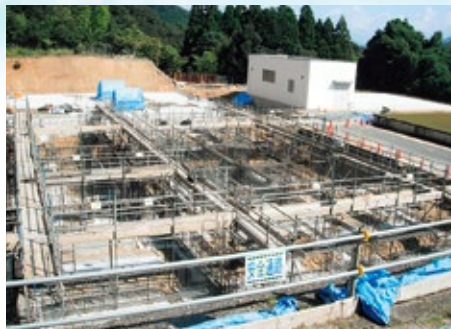
工事中の新管理棟
