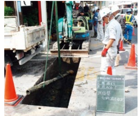
水道管の布設替工事の様子
