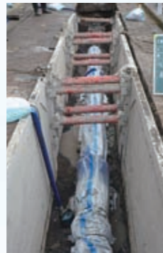
▲更新した水道管
