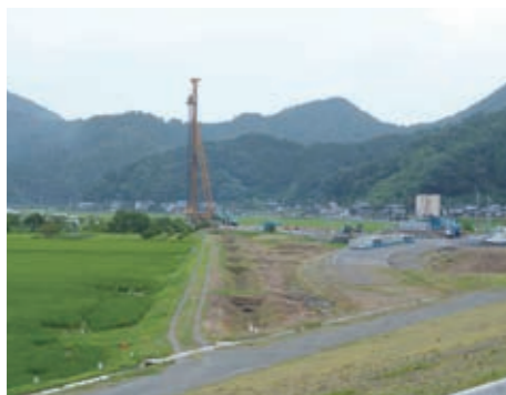
▲輪中堤の整備が進む下東地区
