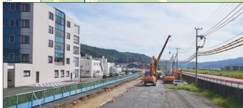
▲整備中の国道27号西舞鶴道路(倉谷)
