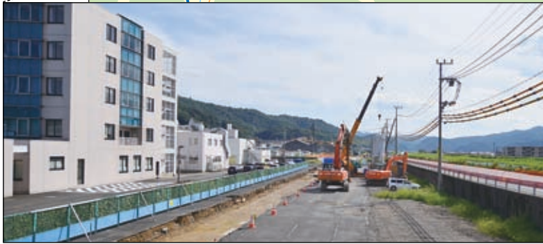
▲整備中の国道27号西舞鶴道路(倉谷)
