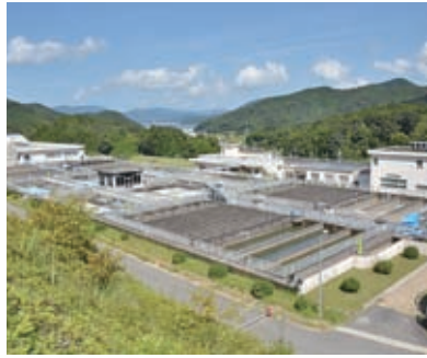
▲上福井浄水場
