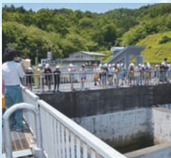
▲上福井浄水場の様子
