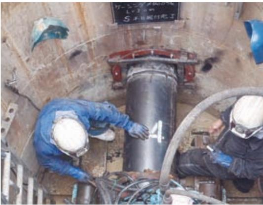
▲下水道管の布設工事(推進工事)
