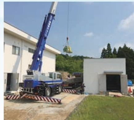
▲上福井浄水場の施設更新工事(ポンプ搬入)。この工事は防衛省の民生安全施設整備事業補助を受け実施。
