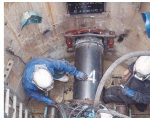
▲下水道管の布設工事(推進工事)
