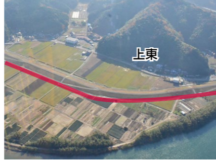
▲右写真中央部に築かれた輪中堤
