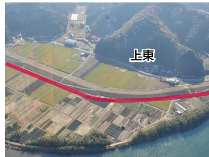
▲右写真中央部に築かれた輪中堤
