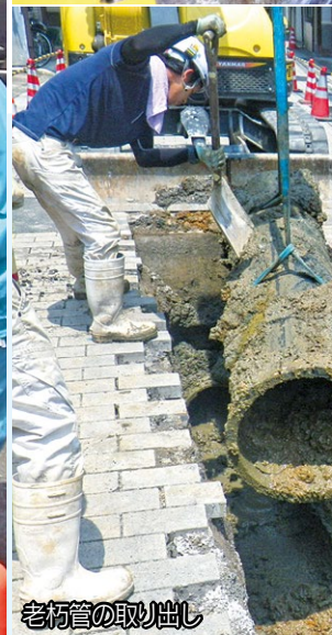
老朽して折れた水道管
