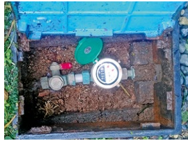
▲水道メーター
