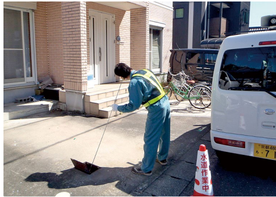
▲メーターに漏水音がないか確認中
