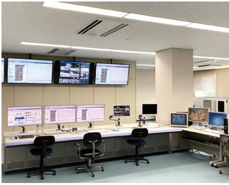
▲整備した上福井浄水場管理センター中央監視室
