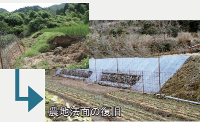
農地法面の復旧
