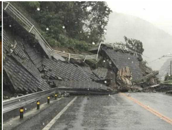
平成 30 年 7 月豪雨 平成 30 年 7 月 5 日～7 日 (国道 27 号土砂崩れ 真倉地区)
