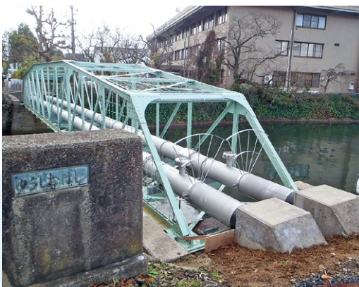
▲潮路通りの寺川に架かる水道橋
