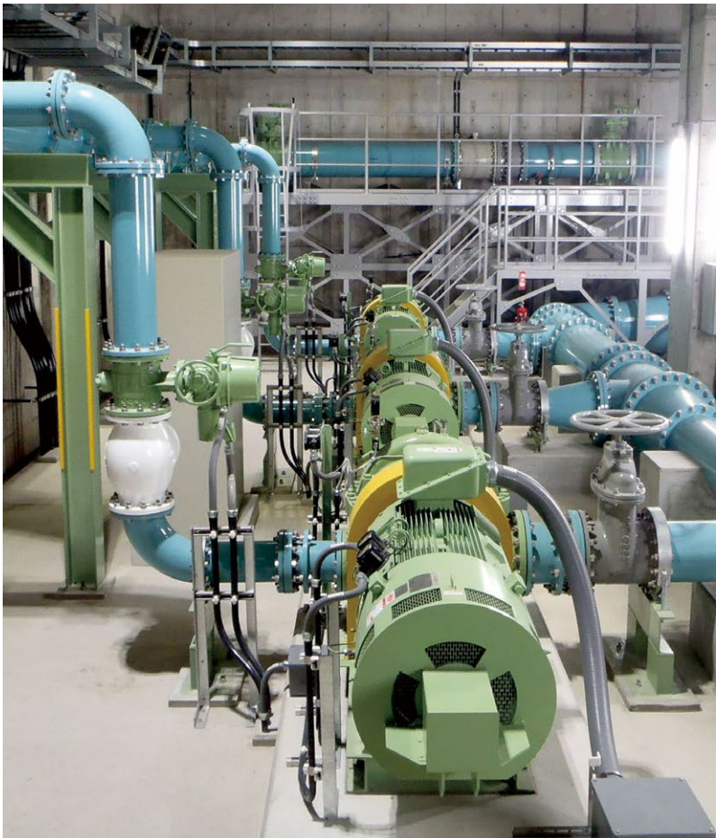
▲上福井浄水場 新ポンプ設備
