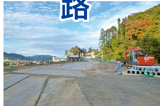
▲切土・擁壁工事(今田)
