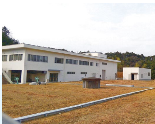
▲上福井浄水場 場内整備
