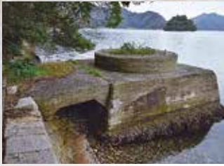
▲重機の基礎と思われる構造物
