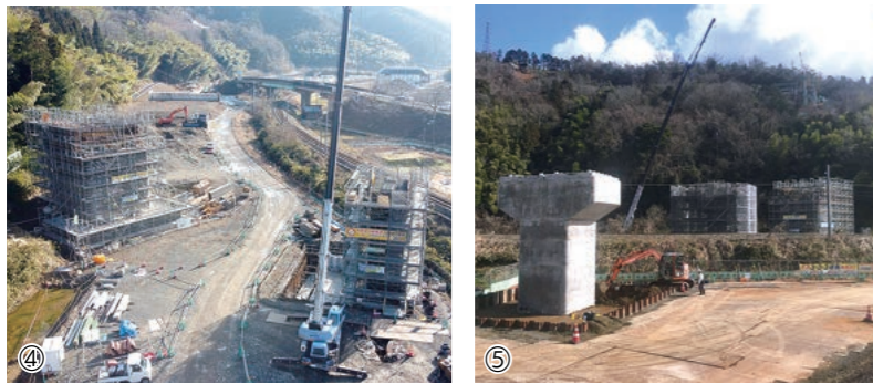
③上空から見た京田地区(道路図はイメージ) ④鉄筋の組み立てやコンクリートの流し込みを行う ⑤現国道側から見た京田地区
