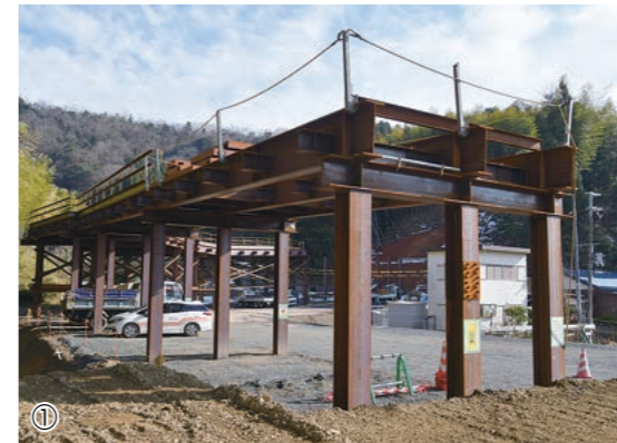
①トンネル工事用仮橋(施工中、上部を作業用機械などが通行) ②上空から見た境谷地区(中央にあるのが工事用仮橋)
