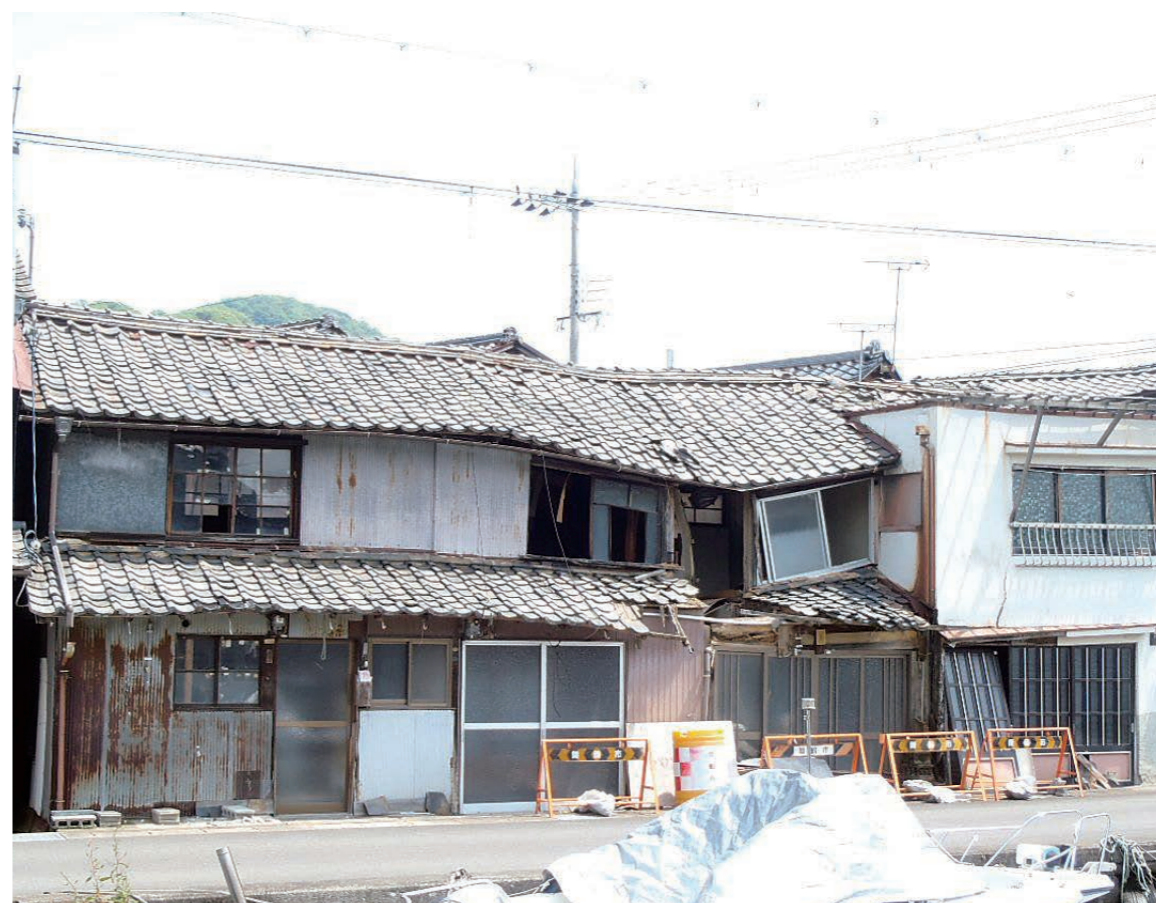
▲倒壊の危険がある空き家
