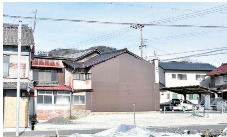
▲所有者の協力で、空き家は除却され更地に
