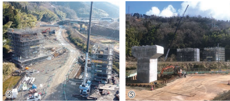
③上空から見た京田地区(道路図はイメージ) ④鉄筋の組み立てやコンクリートの流し込みを行う ⑤現国道側から見た京田地区
