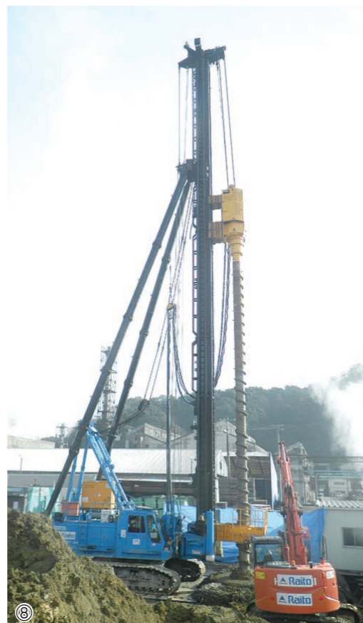
⑥施工管理システム ⑦上空から見た倉谷地区 ⑧青色の機械が地盤改良機。前面にあるドリル状の部分でかき混ぜるなどの作業を行う
