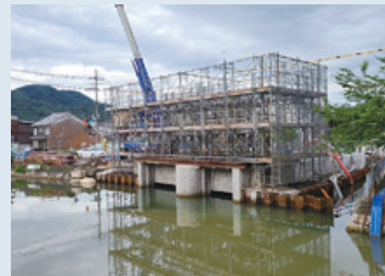
▲建設中の大手ポンプ場
