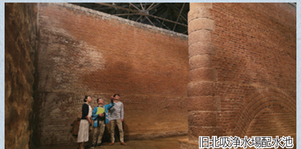
旧北吸浄水場配水池
