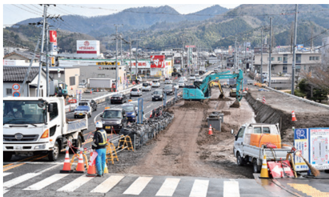
▲二ツ橋付近の4車線工事の様子
