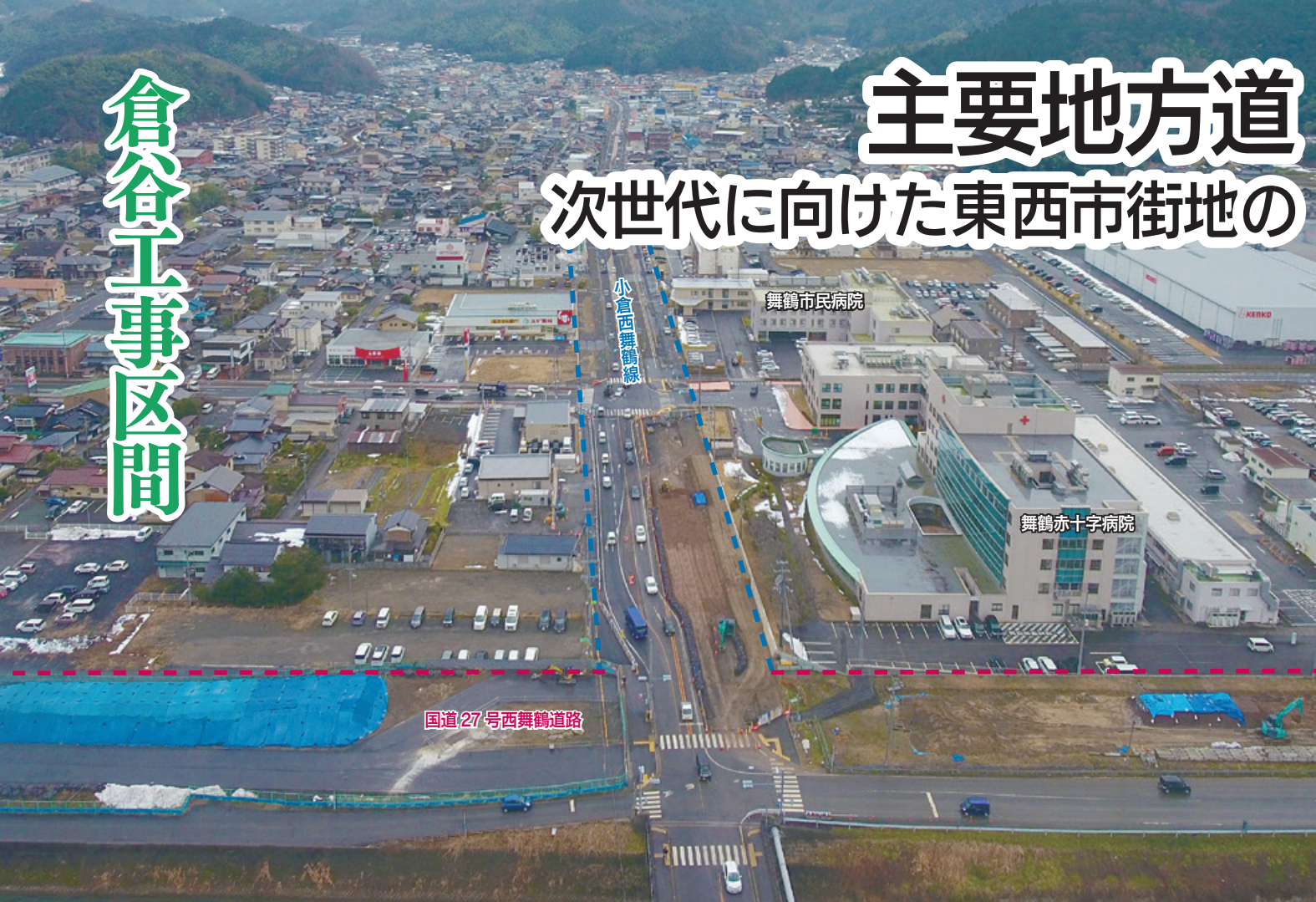
▲倉谷工事区間 (事業者: 中丹東土木事務所提供)
