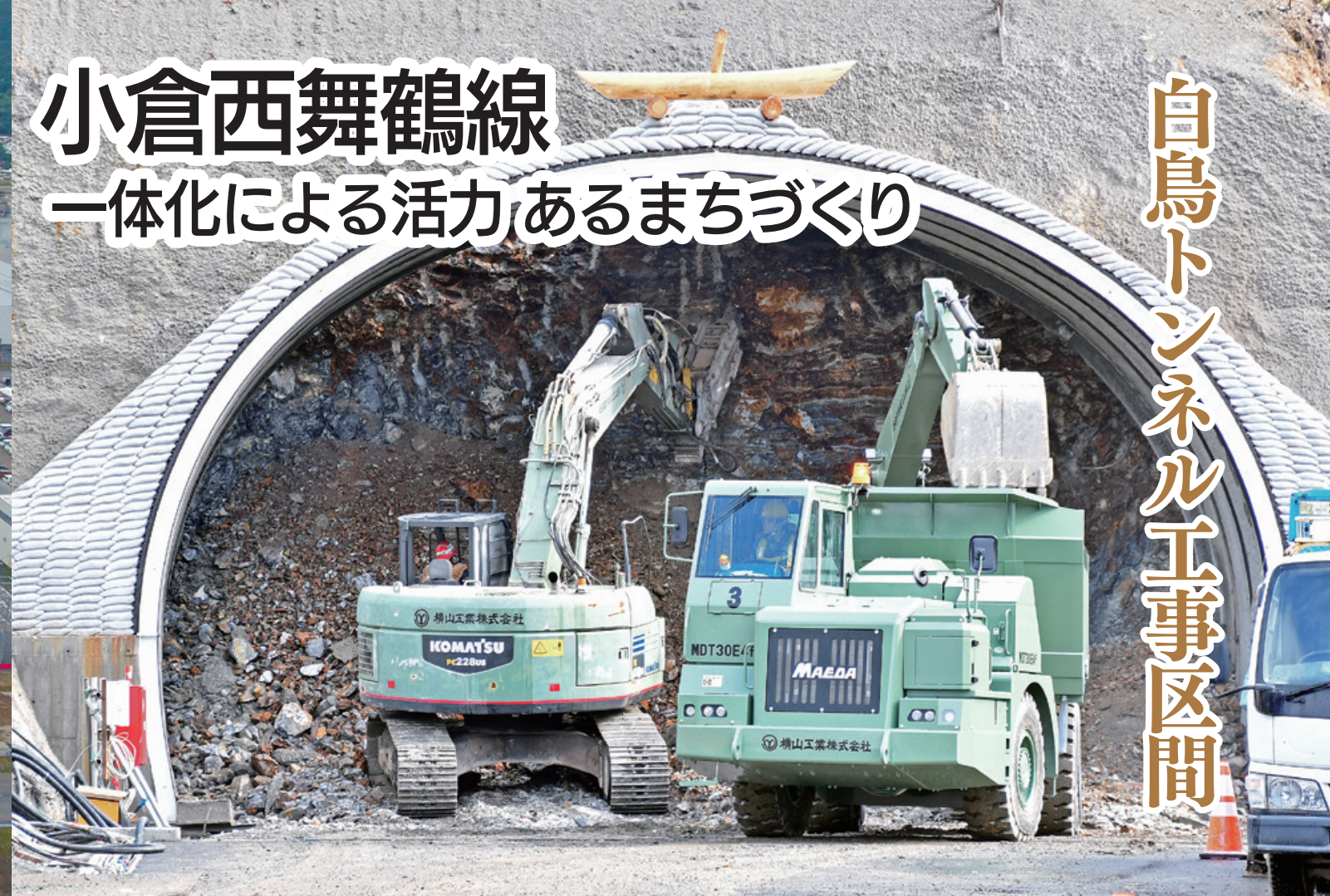
▲新白鳥トンネル(仮称)掘削工事
