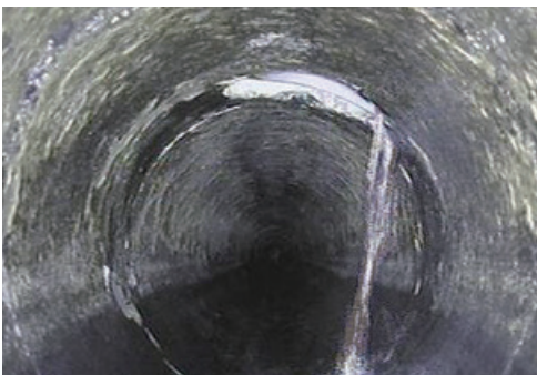
▲老朽化した下水道管
