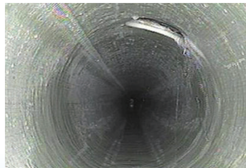
▲工事で修復された下水道管
