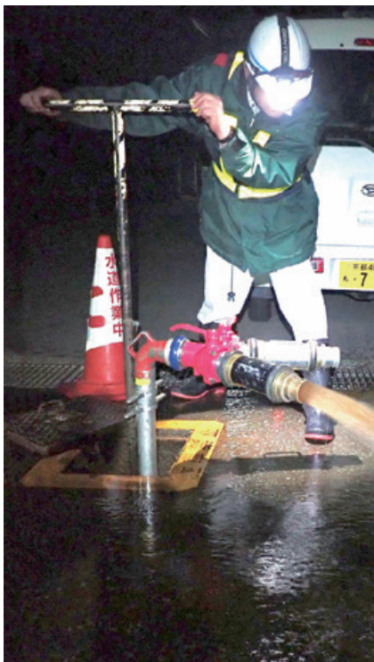
▲水道管の夜間洗浄作業
