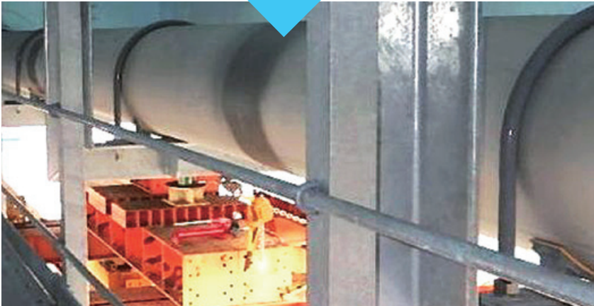
▲橋桁に架設した配水管(直径400 mm )
