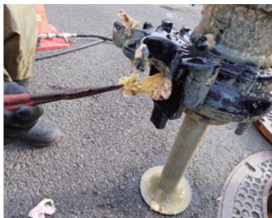
▲ポンプに詰まった異物の除去作業
