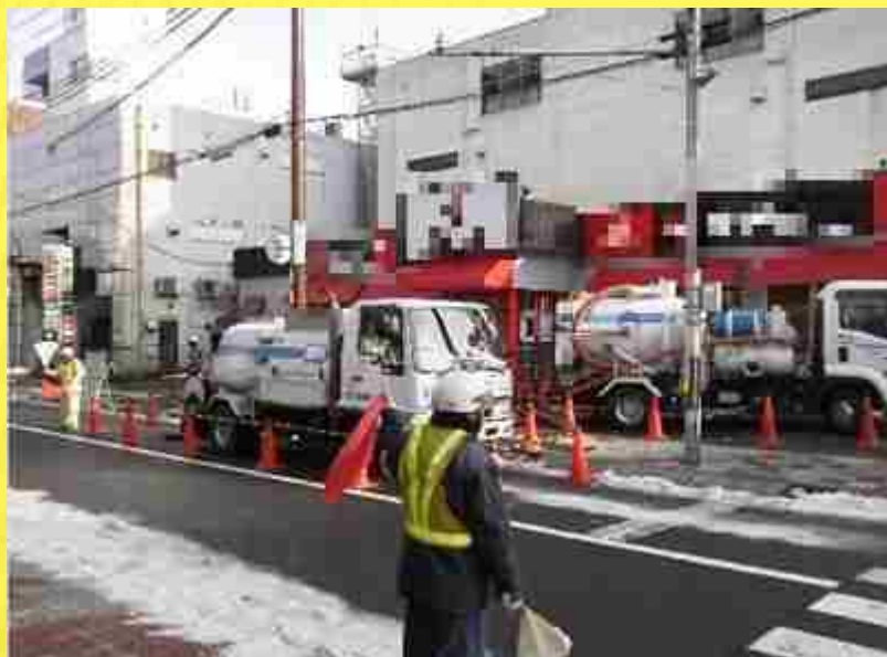
定期的な下水道管の点検・清掃
