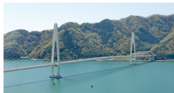
▲定期的に点検・修繕が実施されているクレーンブリッジ
