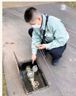
▲水道メーター検針作業
