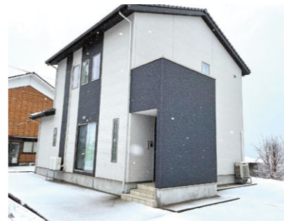
最近建築された建物
