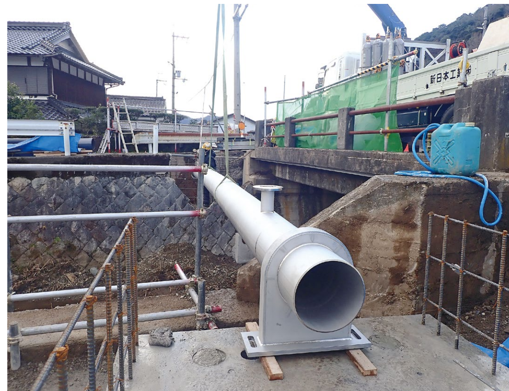
▲令和5年度に実施した管坂橋配水管布設替工事(木ノ下)
