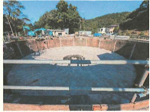
現在の旧九条山沈殿池跡地、宿泊施設が建設される。
