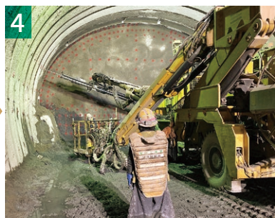
ロックボルトの打ち付け（※）
