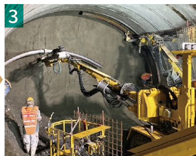
外壁を補強する工事（※）
