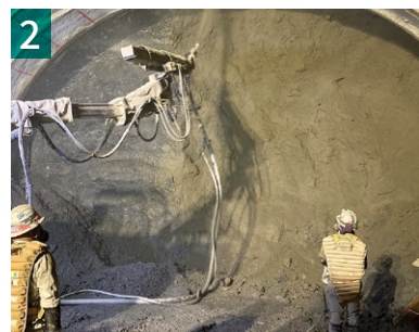
コンクリートを外壁に吹き付け（※）
