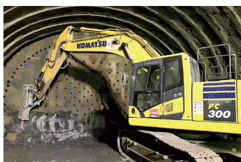
穴を開けて掘削している様子（※）
