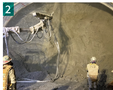
コンクリートを外壁に吹き付け（※）
