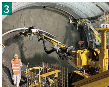
外壁を補強する工事（※）
