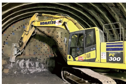
穴を開けて掘削している様子（※）
