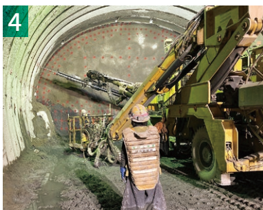
ロックボルトの打ち付け（※）
