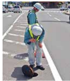
▲音聴棒で水漏れの調査
