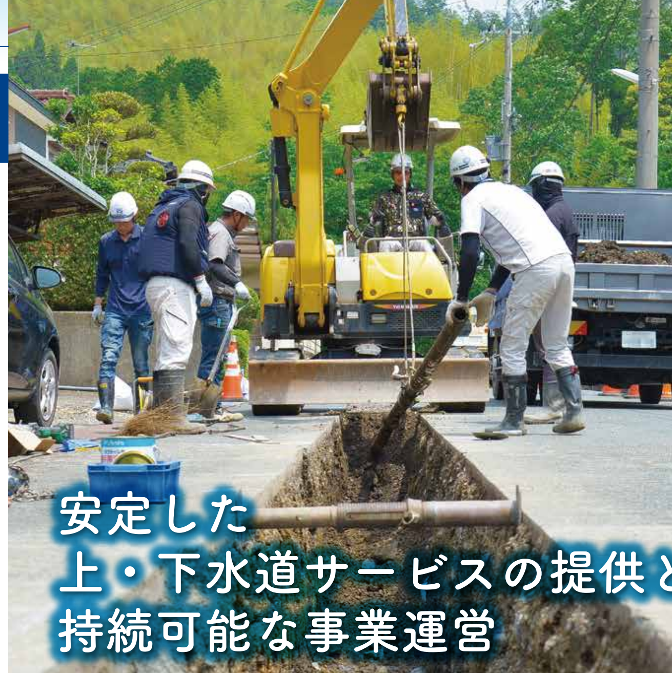
▲老朽化した水道管の入れ替え（昭和台）
