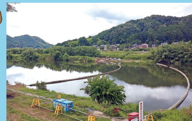
由良川に設置している防潮幕
