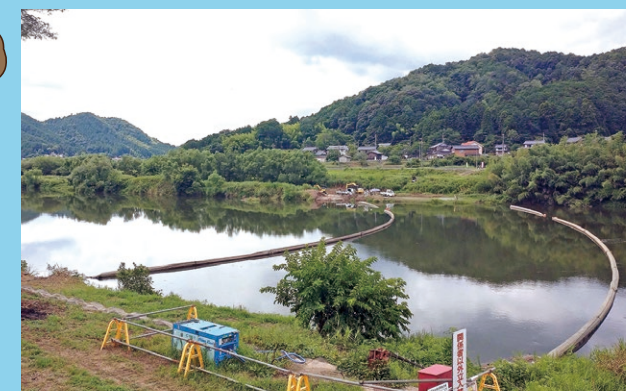
由良川に設置している防潮幕
