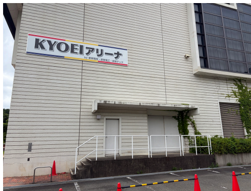
（第一駐車場付近）
